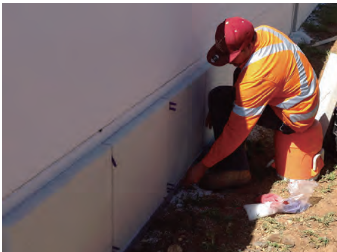
使用弹性触变性粘合剂在现场安装 Reapor。
