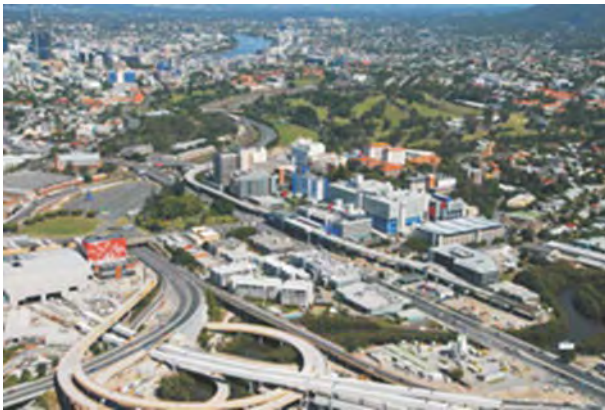
Brisbane 西北路绕行隧道通风井
