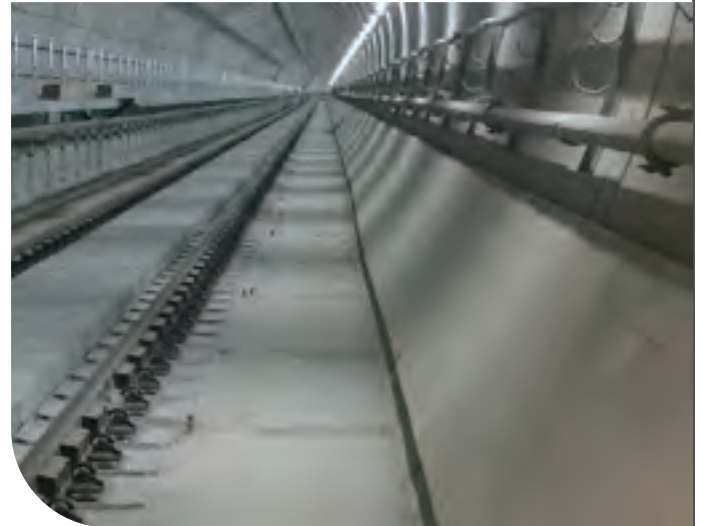
轨道之间的 Viterolite® 900 和墙壁上的 Reapor
