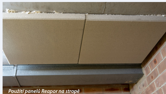
Použití panelů Reapor na stropě
