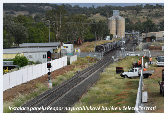
Pravidelná kontrola funkčnosti oplechování
